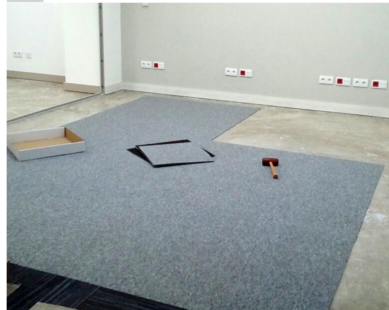
Detalhe da montagem / a plicação do produto.
